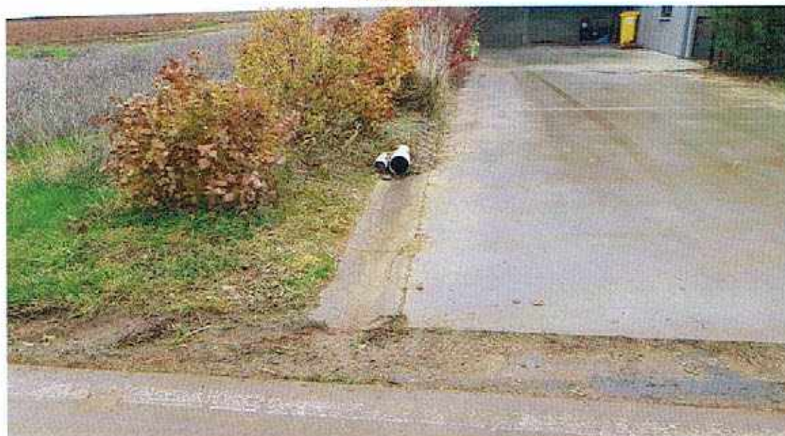
PHOTO 12 - Évacuation existante des eaux de pluie
